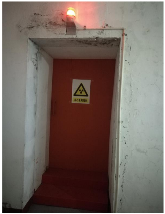
探伤室防护门照片
